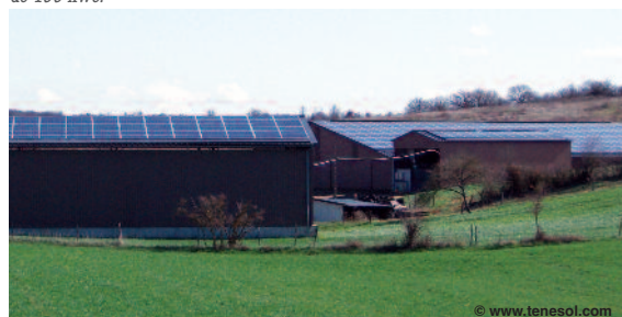
Exemple d'un bâtiment agricole membre d'une coopérative située dans le sud-ouest, qui regroupe 106 exploitations agricoles et équipe en photovoltaïque plus de 200 bâtiments (stabulations, bergerie, stockage) pour une puissance totale installée de près de 7 MWc.
