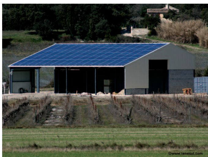
Ce bâtiment située à Saint-Restitut (26) et dédié à la production de plantes aromatiques est équipé de la solution intégrée SIT-M. Les 168 modules Tenesol TE 2200 qui recouvrent les 290 m 2 de la toiture, ont une puissance installée de 39 kWc pour une production estimée à 25 000 kWh par an.
