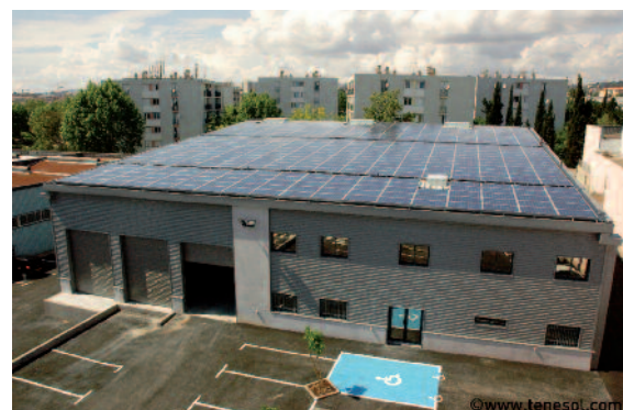
Immeuble industriel, situé à Marseille : l'installation de cette centrale photovoltaïque en toiture impliquait la gestion de l'ensemble du projet technique, notamment la mise en sécurité, les trappes de désenfumages, et les évacuations d'eaux de pluie.
